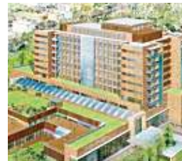
県立がんセンターも建設中
