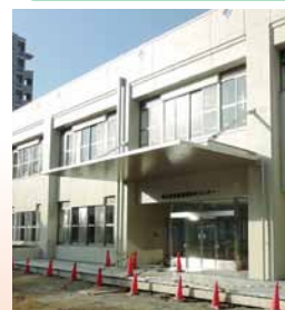
新防災センター稼働
