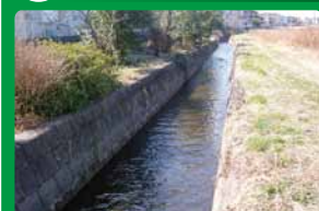
用水路の補修
