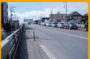
補修工事の実施
