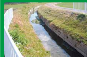
用水路の補修
