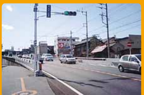
補修工事の実施
