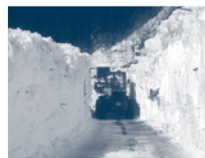
雪崩による雪野壁を切り崩していく重機
