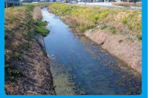
用水路の補修
