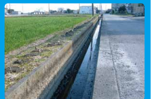
用水路の補修
