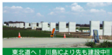
東北道へ! 川島ICより先も建設中!!
